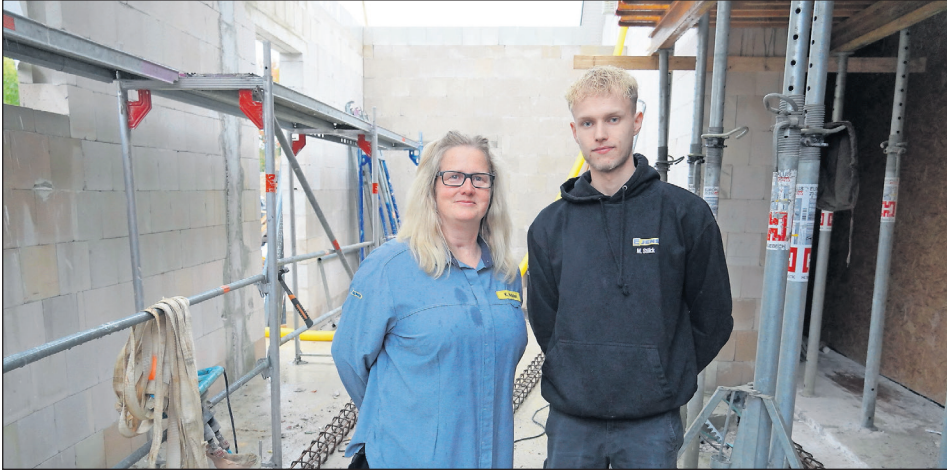
Der Umbau läuft auf Hochtouren. Davon überzeugten sich stellvertretende Marktleiterin Katja Wähler und Mitarbeiter Moritz Stöck.
