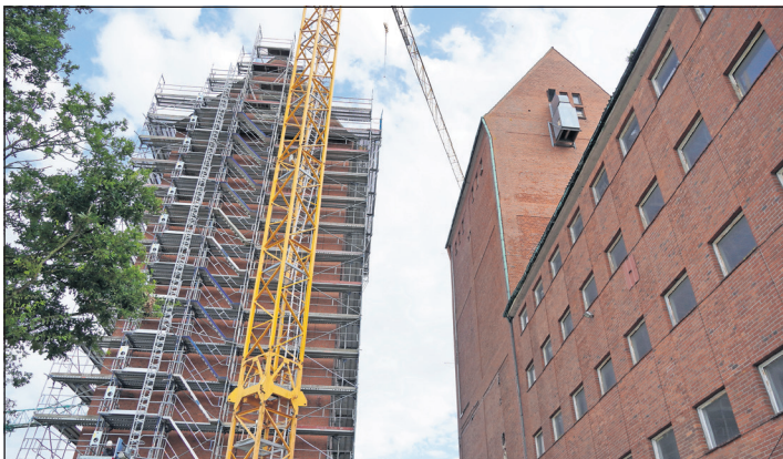
Der Nordturm ist bereits eingerüstet und startklar für den Umbau.
