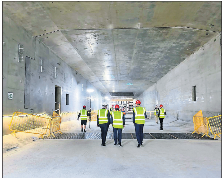
Im Tunnel. (Fotos: Kreis Ostholstein)
