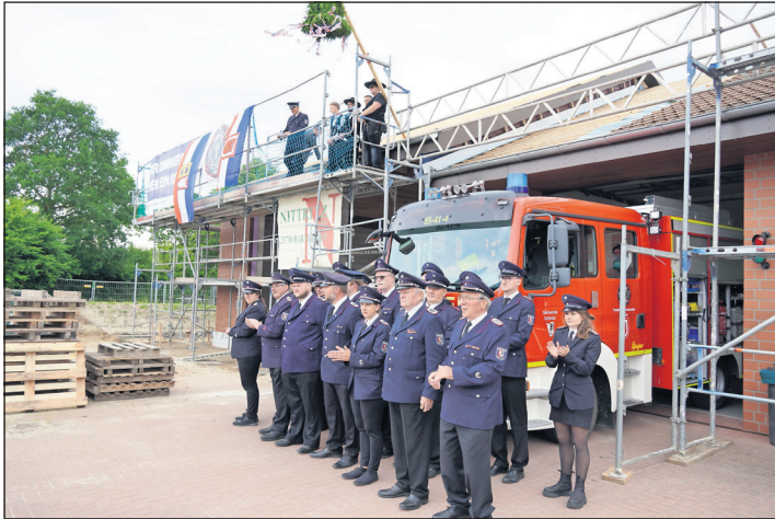
Antreten zum Richtfest: Die Kameradinnen und Kameraden der Guttauer Wehr sind stolz auf den Erweiterungsbau.
