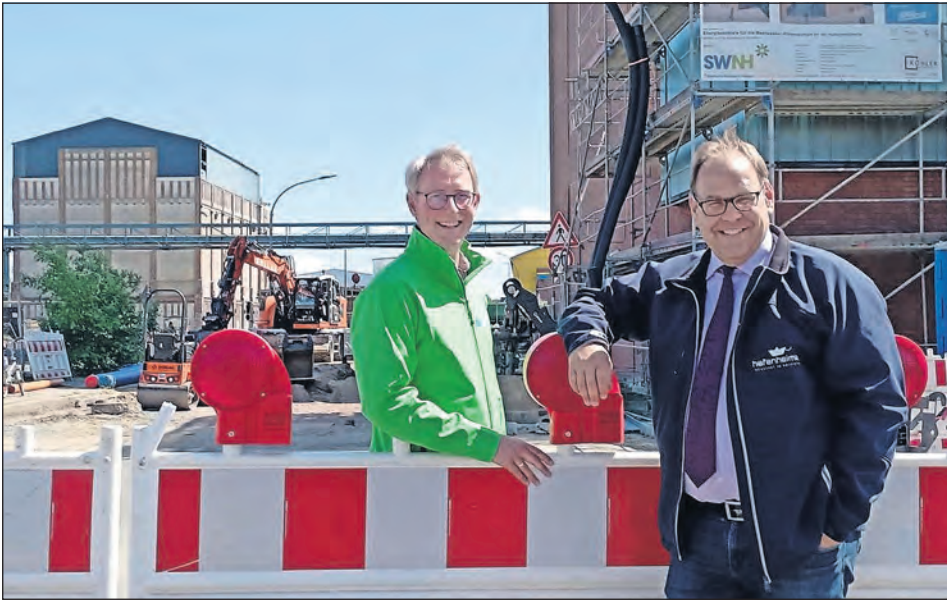
Bürgermeister Mirko Spieckermann (re.) und Werkleiter Dr. Mark Jahn vor dem Bau der Energiezentrale für die Wärmeversorgung der Hafenseite.
