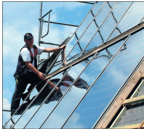
Photovoltaik: Dachdecker wissen, was zu tun ist. (Foto: HF, Redaktion Harald Friedrich/akz-o)
