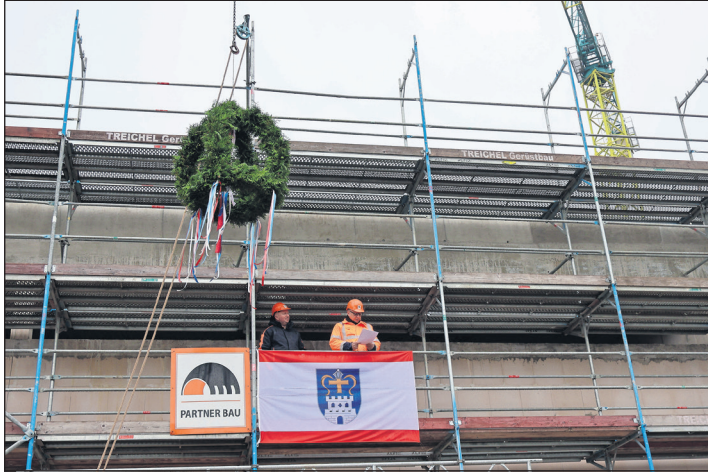
Richtfest für den neuen Teil der Feuerwehrezentrale.
