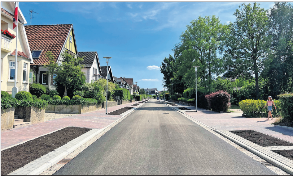
Die Straße Am Heisterbusch kurz nach der Fertigstellung der Sanierungsmaßnahme im Juli 2023 erstrahlt in neuem Glanz.
