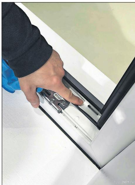
**Die Wasserschlitze im Blendrahmen sollten ebenfalls auf Verschmutzung geprüft und bestenfalls regelmäßig gereinigt werden, sodass Niederschlagswasser aus der Falzluft ungehindert ablaufen kann. (Foto: TMP)**
