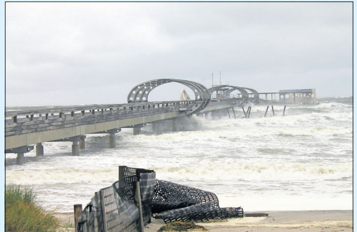
Oktober: Rekordhochwasser hinterlässt Spuren und fordert ein Todesopfer +++ Der 1. Bauabschnitt des Küstengymnasiums ist fertiggestellt +++ Die Bäderregelung wird bis 2028 verlängert +++ In Grömitz, Dahme und Kellenhusen finden nach dem Sturmhochwasser Aufräum-Aktionen statt
