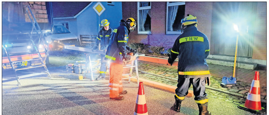
Mit dem Zuschnitt der Holzkonstruktion zur Entlastung des Mauerwerks wurde sofort begonnen.
