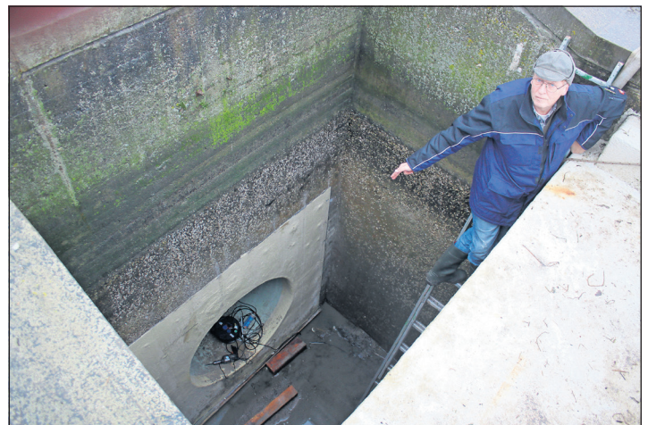
Jochen Langbehn zeigt, wo eine neue Rückschlagklappe eingebaut wird.
