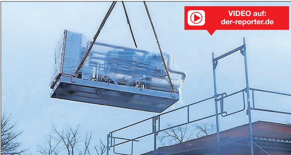
Mit einer Größe von 5,3 Meter Länge, 2,5 Meter Breite, 2,2 Meter Höhe und einem Gewicht von rund 9 Tonnen, wurde die Pumpe mittels eines Krans eingebracht.
