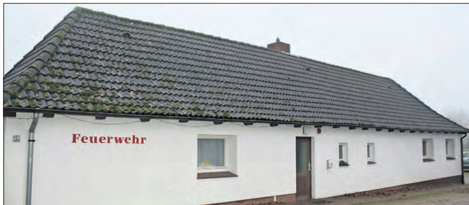
Das Feuerwehrhaus in Lensahnerhof entspricht nicht mehr den geltenden Richtlinien. An grenzend an die Fahrzeughalle entsteht in 2024 ein Neubau.
