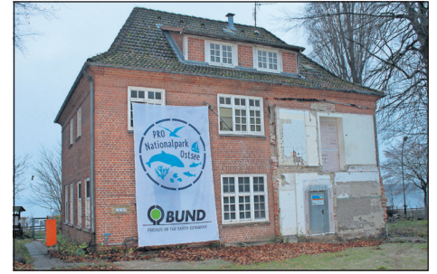
Aktuelle Ansicht: Der ehemalige Anbau ist bereits abgerissen.
