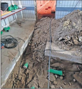
**Schwerstarbeit für die Handwerker:** Im ursprünglich verbauten Beton-Fundament mussten tiefe Gräben ausgehoben werden.
