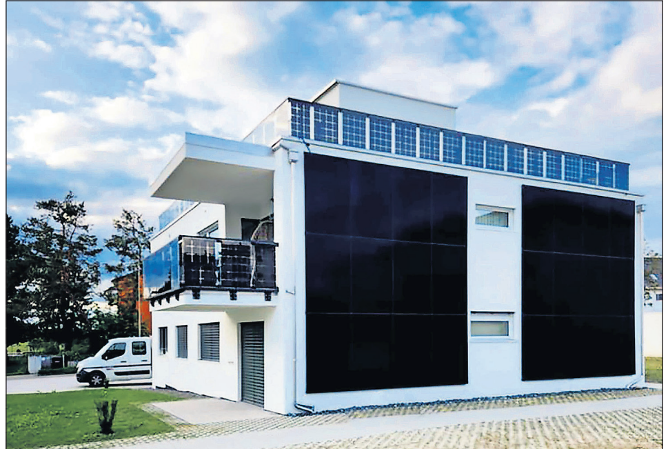
Aus dem Zuhause wird ein Solarkraftwerk: Balkonumrandungen und komplette Fassadenflächen bieten sich für eine umweltfreundliche Energiegewinnung an. (Foto: DJD/www.solarcarporte.de)
