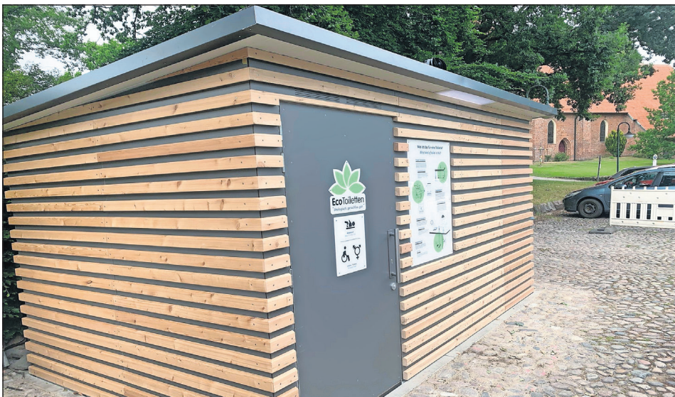
Die neue Toilettenanlage auf dem Lensahner Kirchplatz.
