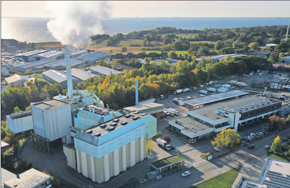
Mehr Nachhaltigkeit: Auf dem Gelände des Müllheizkraftwerkes wird zukünftig Klärschlamm getrocknet, um Masse einzusparen und Transportkosten zu senken. (Foto: ZVO)
