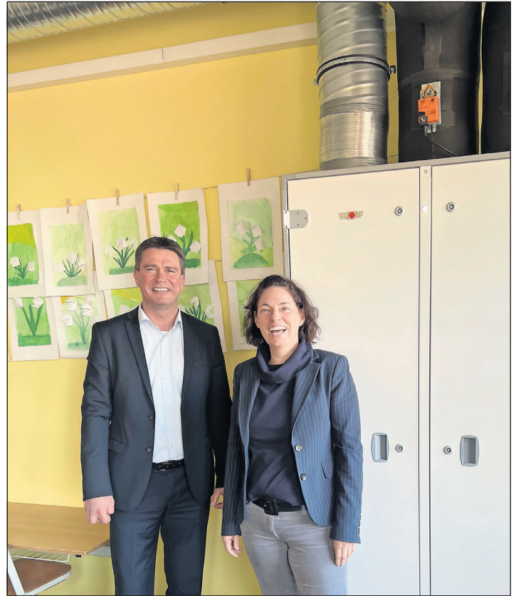
Amtsvorsteher Michael Robien und Schulleiterin Angela Haar vor einer der 27 raumluftechnischen Anlagen.
