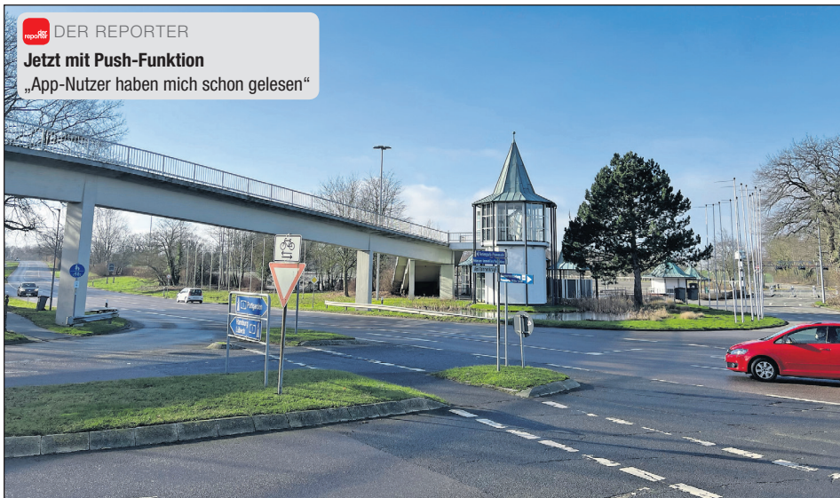
Die Überquerung der Kreuzung Bäderstraße/Am Fahrenkrog auf Höhe des Hansa-Parks kann insbesondere im Winter für Fußgänger gefährlich sein.
