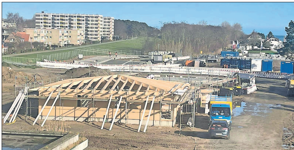
Gebäude „8e“ steht, nun sollen die weiteren vier Einheiten folgen.
