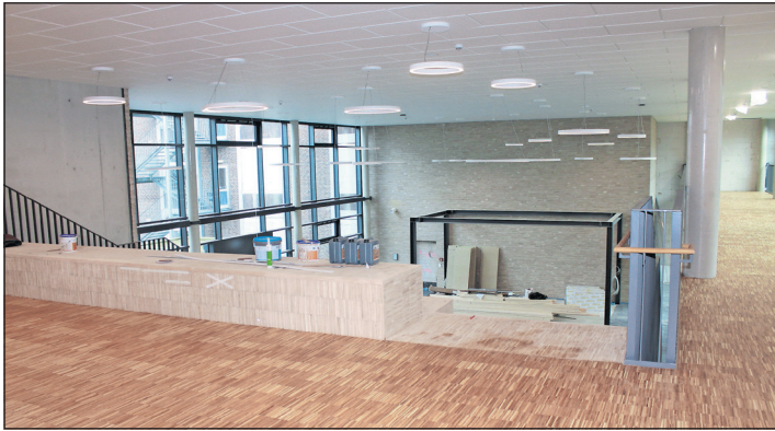
Die neue Aula bietet Platz für die unterschiedlichsten Veranstaltungen.
