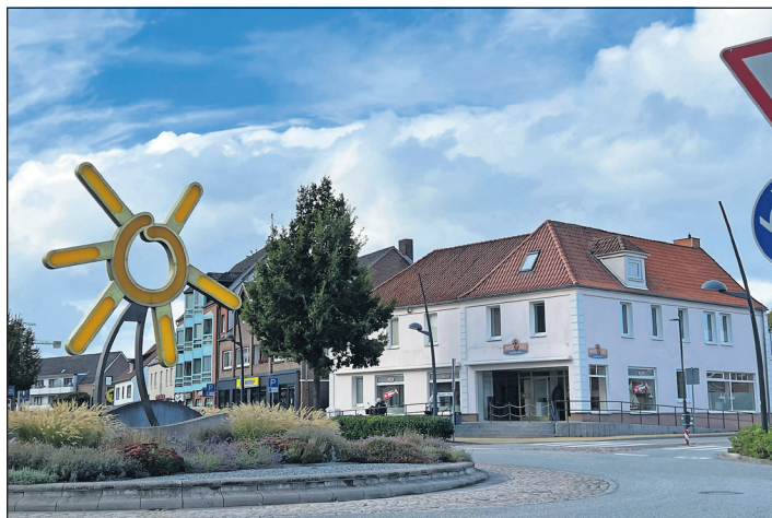
Die neue Tagespflege-Einrichtung in Grömitz ist zentral gelegen und befindet sich am Markt 5.
