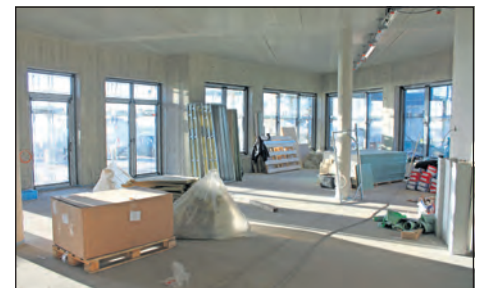
Im Foyer des DLRG-Gebäudes befindet sich der große Speisesaal.
