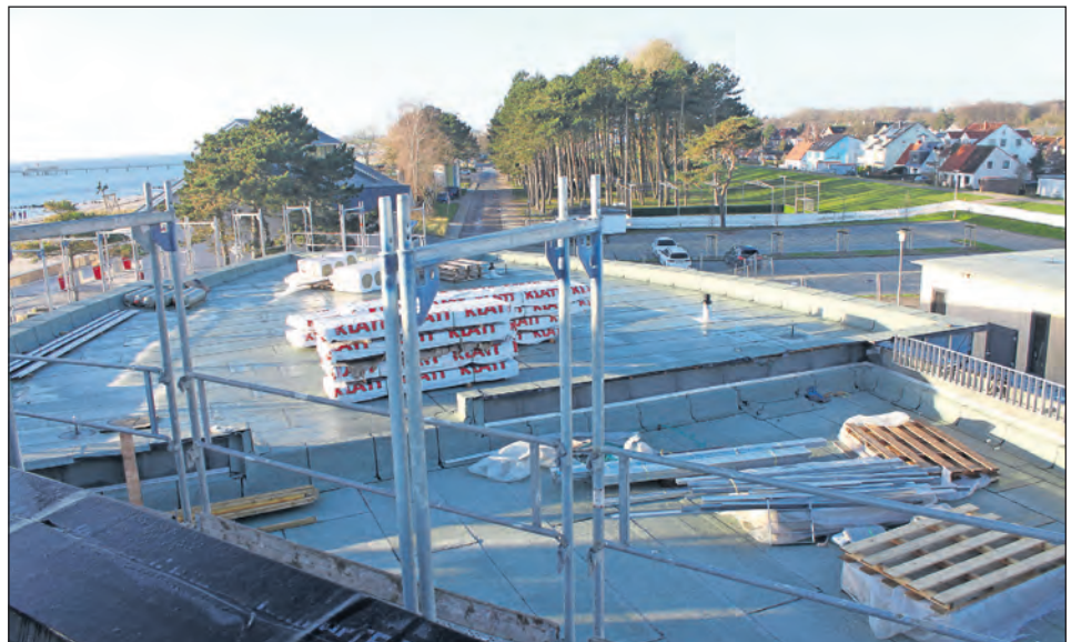
Hier können die Rettungsschwimmer zukünftig eine Dachterrasse nutzen.
