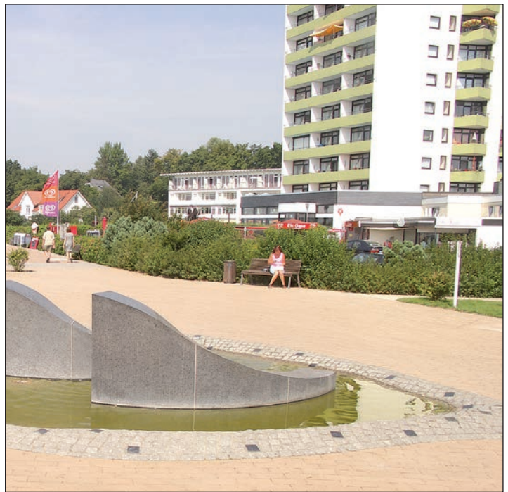
Die flachen Gebäude (re.) zwischen „Prinz Hamlet“ und dem Seebrückenvorplatz werden demnächst abgerissen.
