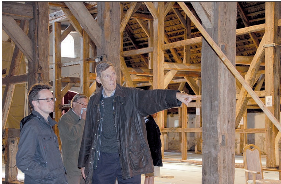
Dr. Constantin Stahlberg (re.) erläuterte den Umbau der Reetscheune.
