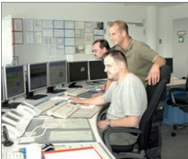
Arbeiten in den Sommermonaten besonders eng zusammen: Frank Wasserberg, Stephan Gerstmann und Oliver Kirpal (v. lks.), die sich in der Zentralwarte einen Überblick über die Auslastung des Trinkwassernetzes verschaffen.
