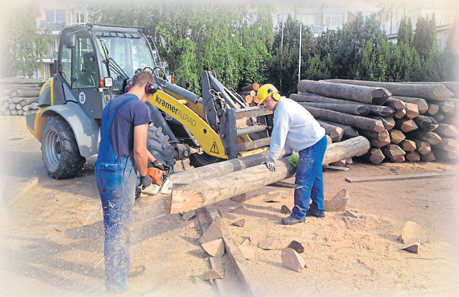
Auf dem Gelände am Südstrand 54 werden die Eukalyptusholzpfähle vorbereitet
