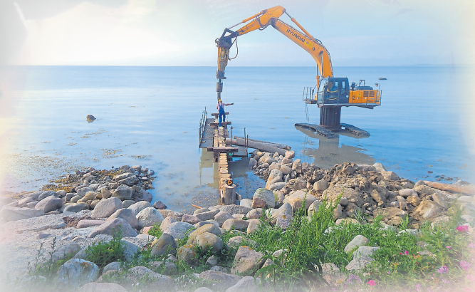
Die ersten Bühnen waren Donnerstag bereits eingetrieben
