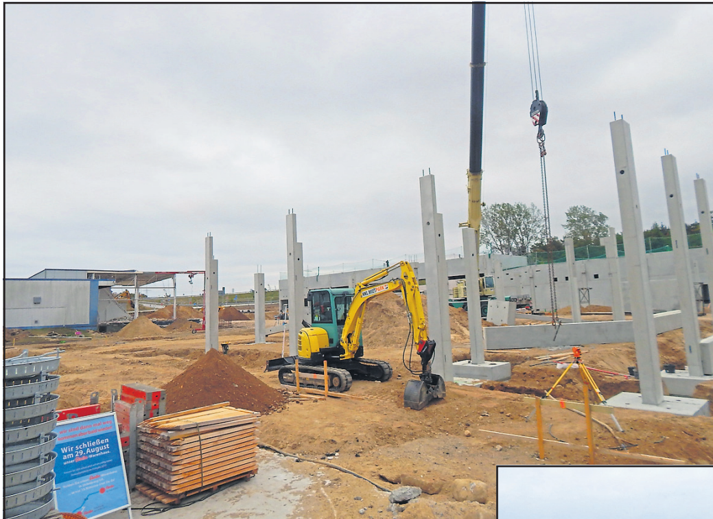
Blickrichtung Autobahn-links der begonnene Abriss des alten Gebäudes
