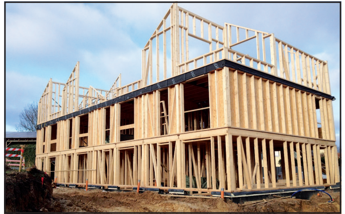
Holzrahmenbau: 6 cm Holz dämmen so gut wie 35 cm Kalksandstein oder 1 Meter Beton.
