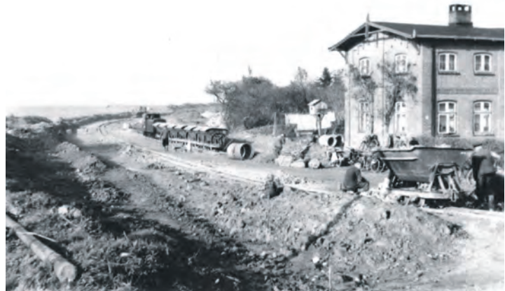
Ende der 1950 Jahre war der Bau der Milchstraße auf einer in Teilen völlig neuen Strecke ein großes Unterfangen zu dem neben vielen Bauarbeitern auch schwere Maschinen bis hin zur Feldbahnen zum Einsatz kamen. Foto: Dobkowitz
