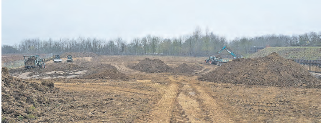
Erdhaufen über Erdhaufen türmen sich zurzeit auf dem Baugrundstück auf.
