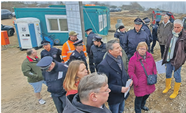
Vertreter von Baufirmen, Rathaus, Kommunalpolitik und Feuerwehr waren beim Tiefbau-Start dabei. Vorab wurden Anschlüsse für Baustrom und Bauwasser vor Ort verlegt sowie Büro- und WC-Container für das Bauteam aufgestellt.
