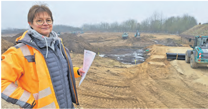
Bauleiterin Anja Plewa steht am Rande der Großbaustelle. In den nächsten vier Monaten werden hier riesige Mengen Erde bewegt.
