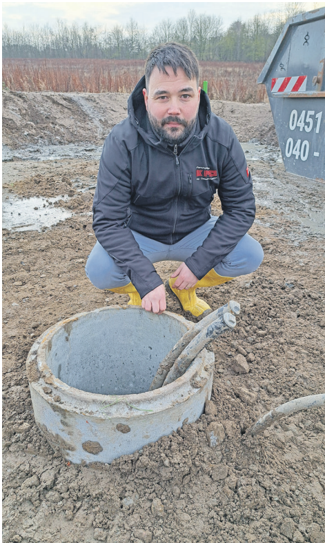
Testbohrung: KMO-Mitarbeiter Nikolai Bechen zeigt den ersten von später 17 Geothermie-Schächten.
