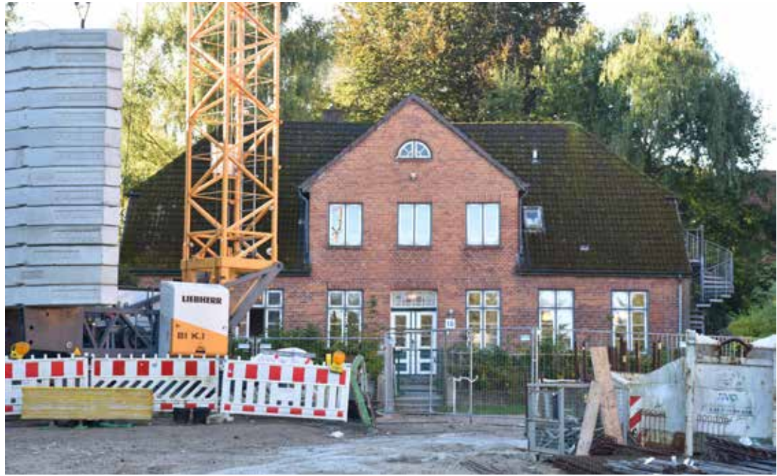
Auf dem Feddersen-Hof wird gebaut. Ob das Montessori-Haus an dieser Stelle bleiben wird, steht noch nicht fest.
