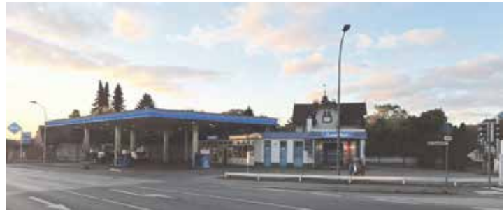
Auch während der Straßensanierung geöffnet: Die Aral-Tankstelle in der Bürgermeister-Steenbock-Straße hat eine neue Pächterin.
