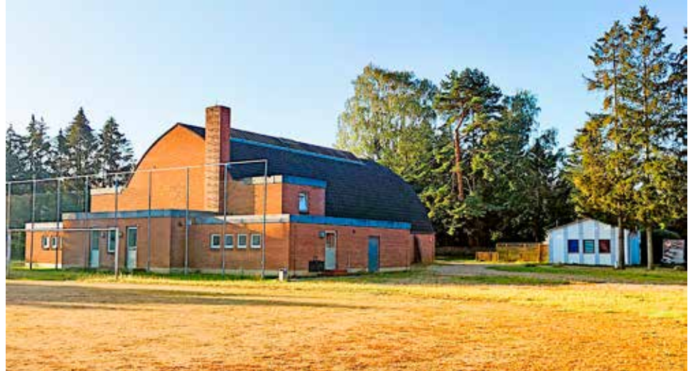
Die Turnhalle aus dem Jahr 1927 wurde von dem bekannten Malenter Architekten Alfred Schulze geplant. Die eingebaute Konstruktion des Zollingerdachs steht in vielen Regionen unter Denkmalschutz. Das Sportlerheim rechts im Bild soll als Büro dienen. Foto: Burgdorf
