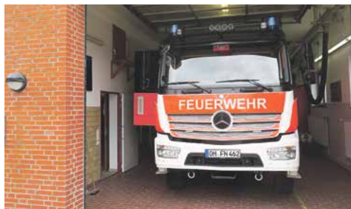
Gerätehaus der Ortswehr Neudorf mit Stellplatz für das Einsatzfahrzeug.
