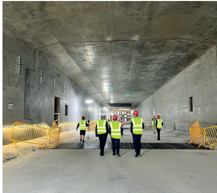
Die Tunnelemente, die in der Ostsee versenkt werden, haben gigantische Ausmaße.
