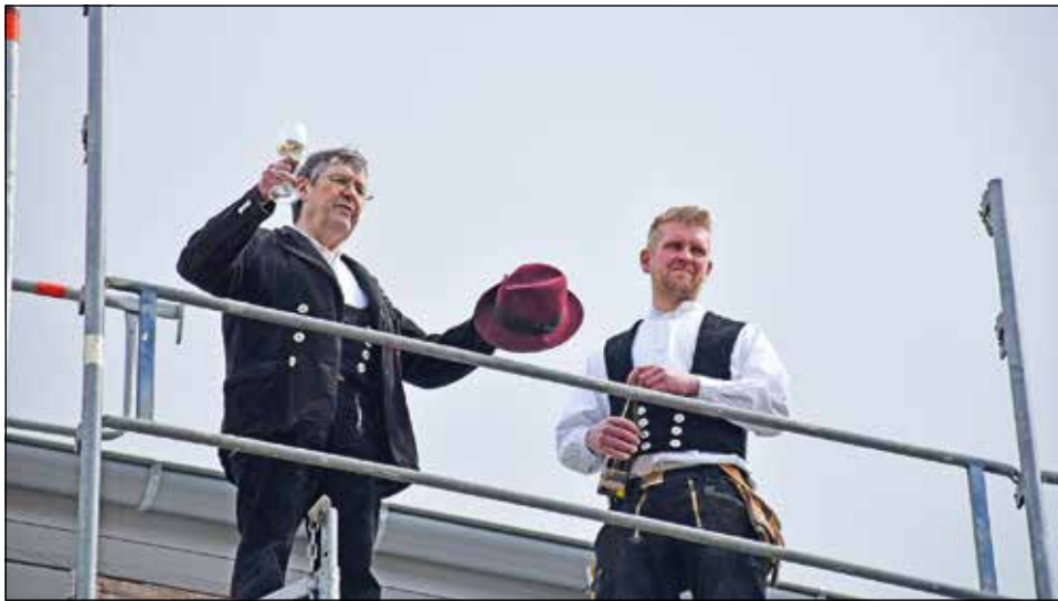
Den traditionellen Richtspruch überbrachte Zimmermeister Werner Rick (links), der sein Glas auf das Haus und die am Bau beteiligten Personen erhob. Unterstützt wurde er an der Dachkante von Zimmermeister Christopher Reßmann.
