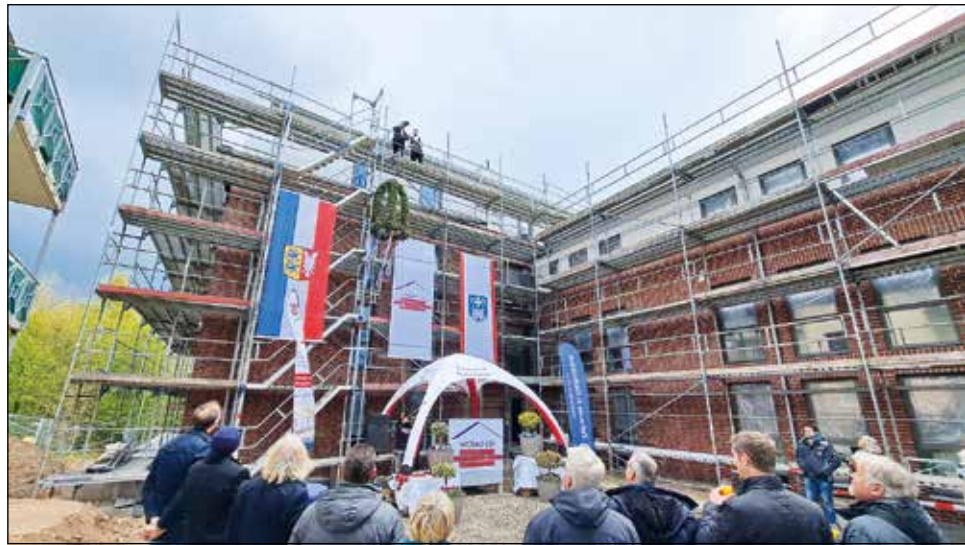
Vor zehn Monaten hatte der Bau der 24 Wohneinheiten begonnen.
