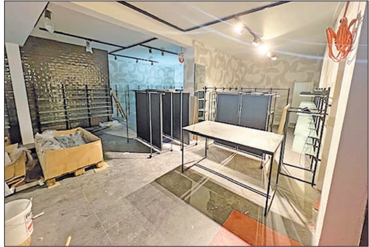
Noch 10 Tage vor Eröffnungstermin präsentierte sich das Geschäft als Baustelle...
