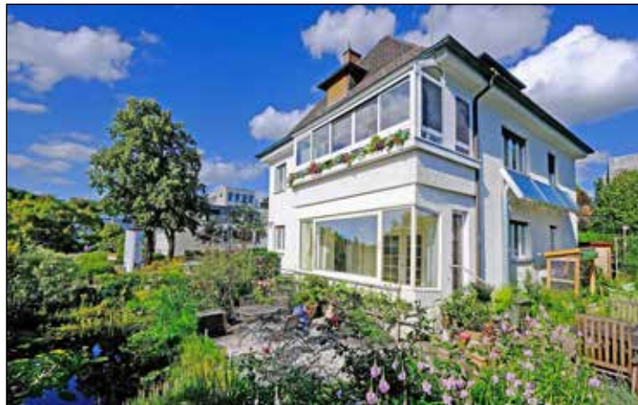
Eine Solarlüftung an der Südfassade sorgt jetzt für ein besseres Raumklima im Keller.
