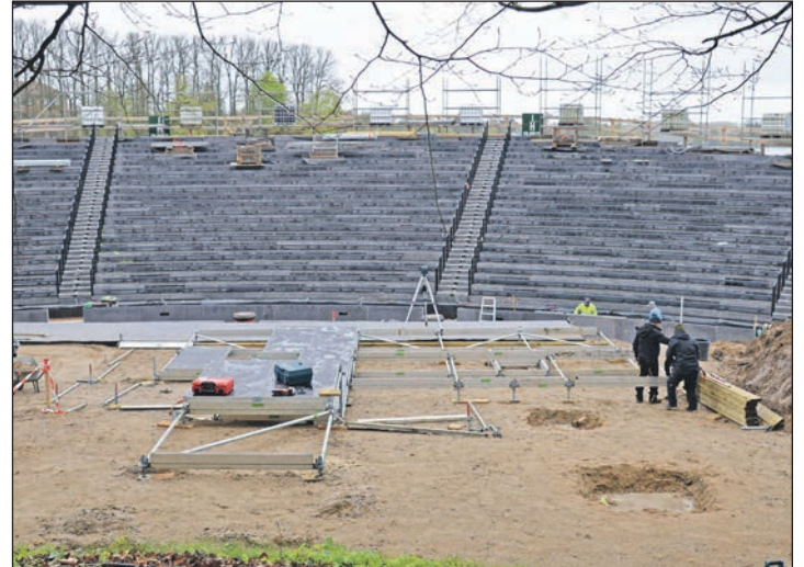
Der grüne Hügel wurde so weit hergerichtet, dass mit dem Aufbau der Bühnenpodeste begonnen werden konnte. Fotos: Krauskopi/hfr
