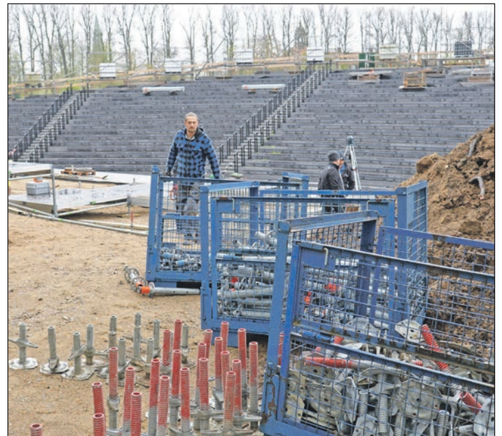
Am Montag wurden die ersten Teile für die Bühnen-Grundkonstruktion angeliefert.
