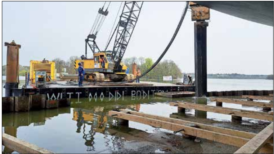
Von der Seeseite aus werden die Spundwand-Teile aus der Erde gezogen bzw. gerüttelt. Der Kran steht auf einem Arbeitsponton.
