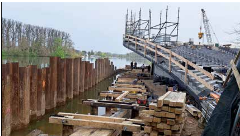
Um die geschwungene Tribünen-Betonschüssel herum entsteht am Ufer des Großen Eutiner Sees ein Holzsteg.
