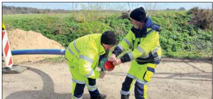
Monteure der Gemeindewerke Malente arbeiten an der neuen Löschwasserleitung für Drögendiek. Foto: hfr
