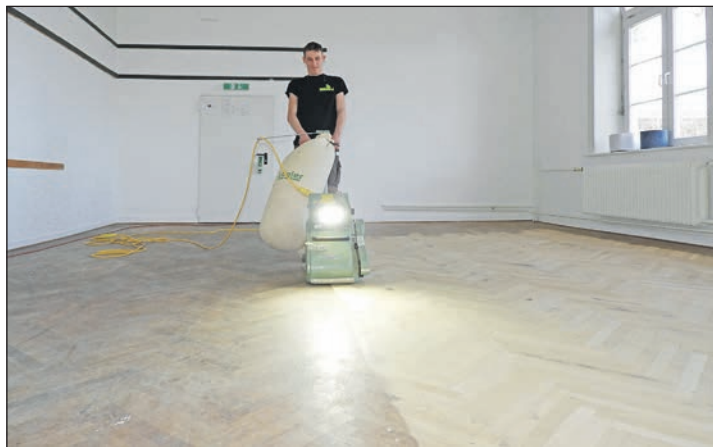
Vorher-Nachher-Effekt: Viktor bringt mit der Schleifmaschine das Parkett, das in diesem Raum nicht erneuert werden muss, auf Vordermann.
