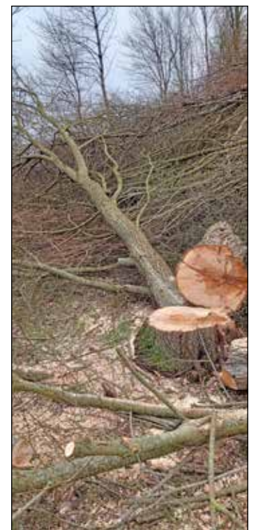
Die Fällarbeiten nahm der Landesbetrieb Straßenbau und Verkehr im Rahmen der „regelmäßigen Gehölzpflege“ vor.
