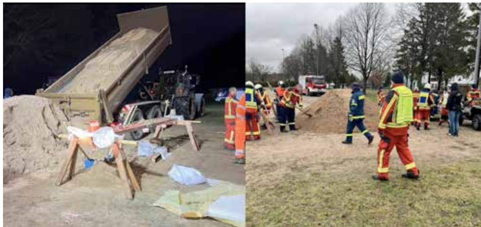
Mit vereinten Kräften konnten die Helfer mit tonnenweise Kies eine Überschwemmung verhindern. Foto Godow
