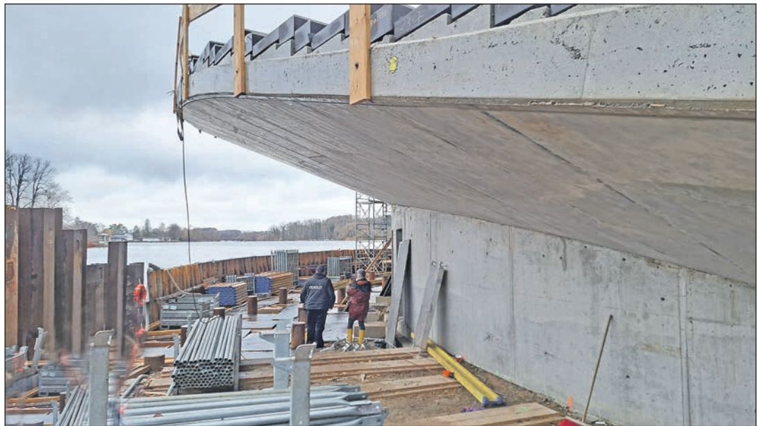
Die Hörnchen-Form der Zuschauertribüne zeichnet sich auch auf der Rückseite ab. Um die Betonschüssel herum soll ein Steg verlaufen.
