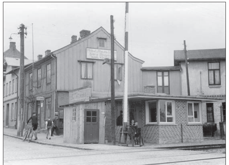
Bahnübergang an der Weidestraße
