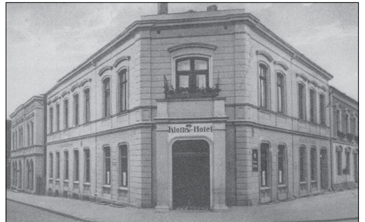
Kloth's Hotel, Peterstraße Ecke Auguststraße (Albert-Mahlstedt-Straße).
