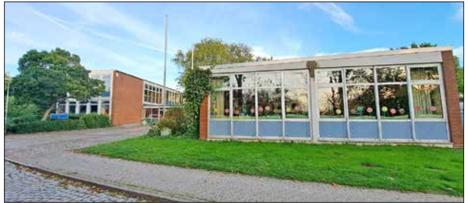
Die maroden Gebäude der Schule am Kleinen See sollen weiterhin einem Neubau weichen.
