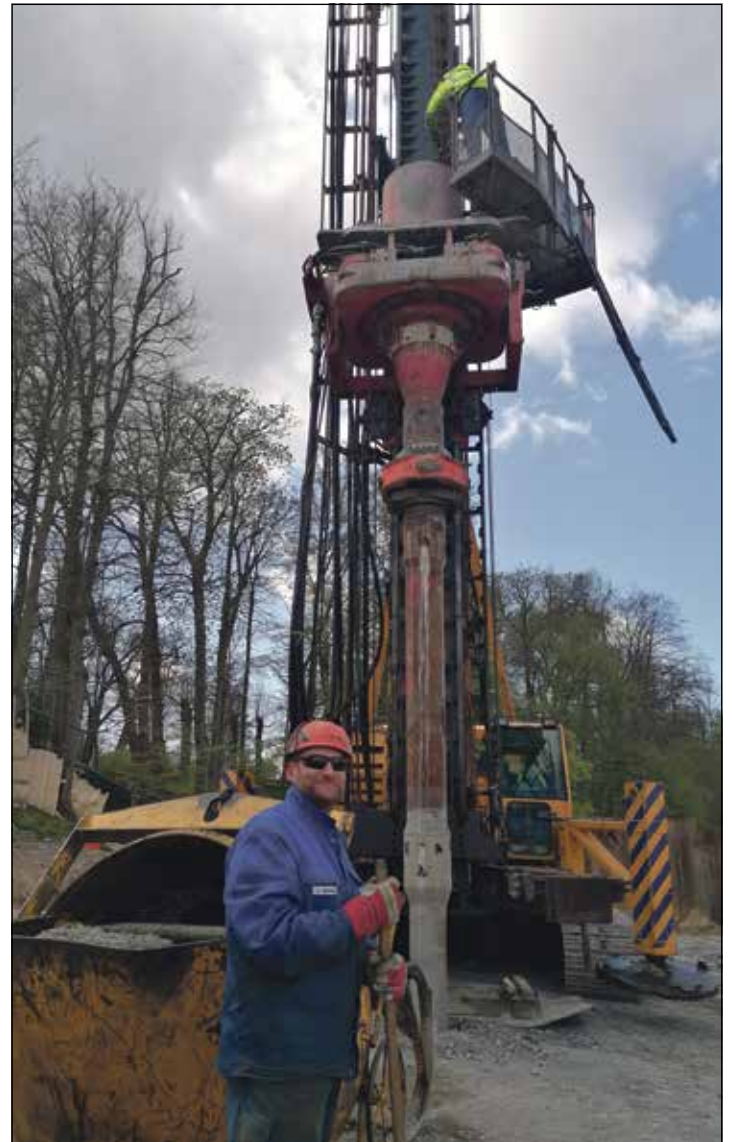
Lars Schneider kennt viele Baustellen, die Eutiner ist besonders.
