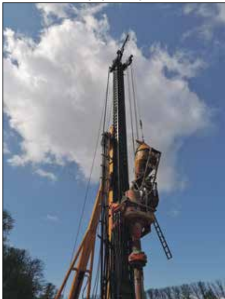
Eindrucksvoll: Mit Beton werden die Bohrungshohlräume ausgegossen.
