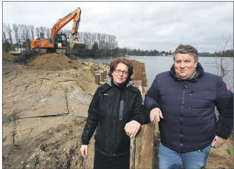
Während die Bagger dafür sorgen, dass die neue Tribüne in 2024 fertig ist, können Anna-Luise Hoffmann und Falk Herzog ein stimmiges Programm für dieses Jahr vorlegen.
