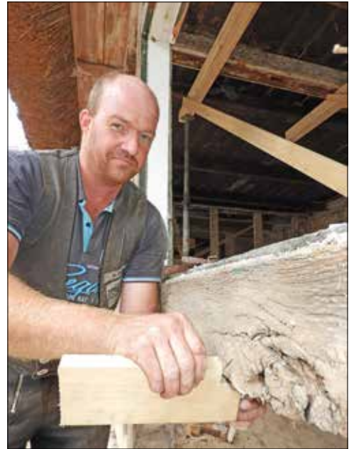
Zimmerer Marco Ehrich zieht die Balken des Fachwerkes ab.
